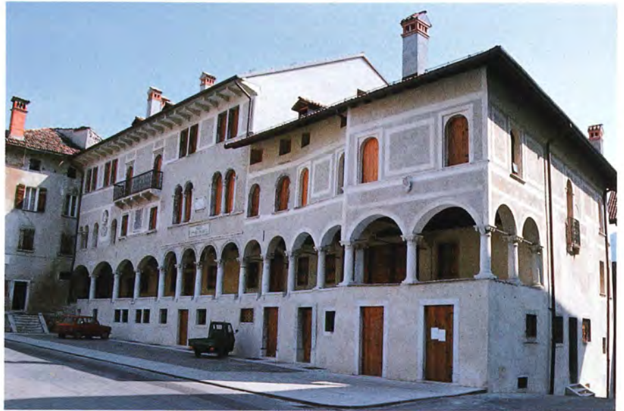
I PALAZZETTI FELTRE Risalgono al 1470 - 1480 circa Ristrutturazione ed interventi globali
