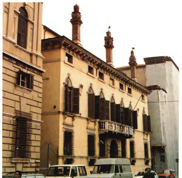
BANCA D'ITALIA FILIALE DI VERONA Ristrutturazione e restauro del secondo e terzo piano
